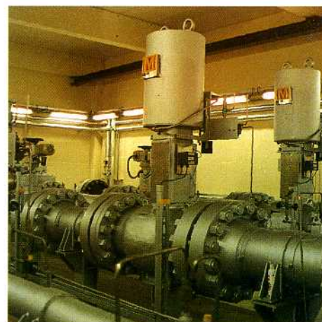
Клапаны HIPPS 24" ANSI 900 фунтов на газовой установке в Зеебрюгге, Бельгия
